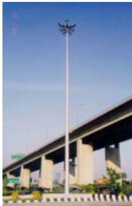
High mast 25 m.
